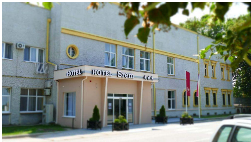
Илустрација 23 – ЗОНА 6, Хотел „Срем“након реконструкције улаза
